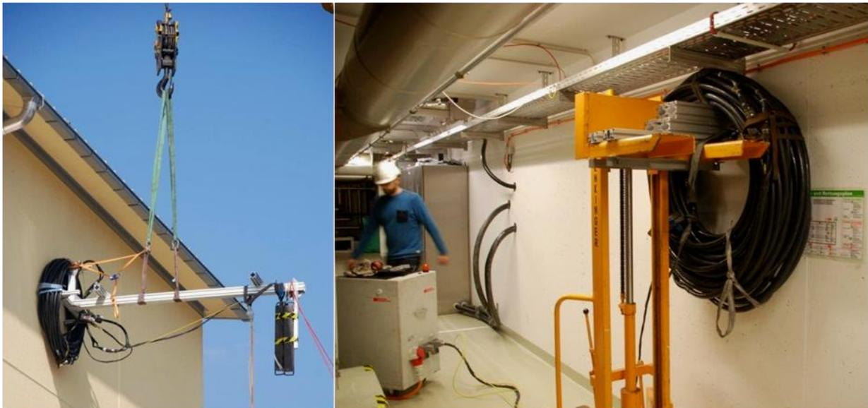
*Puls Entmagnetisierung der ca. 30x20x15m grossen KATRIN-Halle mit mobilem Leistungsmodul MM DM200-PC und flexiblen Entmagnetisierungskabeln K8/10-30. Mit zwei parallel arbeitenden Entmagnetiserteams betrug der benötigte Zeitaufwand zur Entmagnetisierung der kritischen Bereiche ca. 20 Stunden.*
