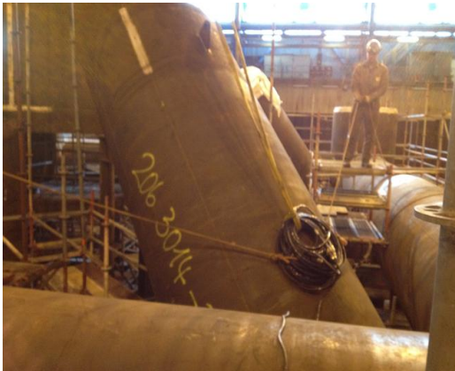
Entmagnetisieren von Konstruktionsrohren
