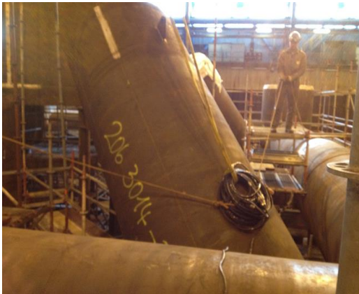
Démagnétisation de tubes de construction
